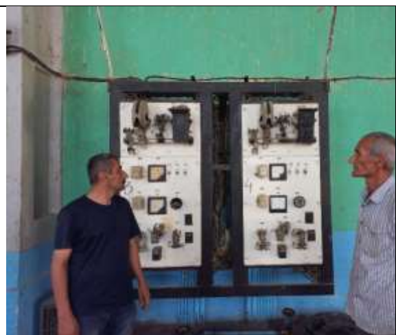
Обследование счетчиков на ГНС-2
