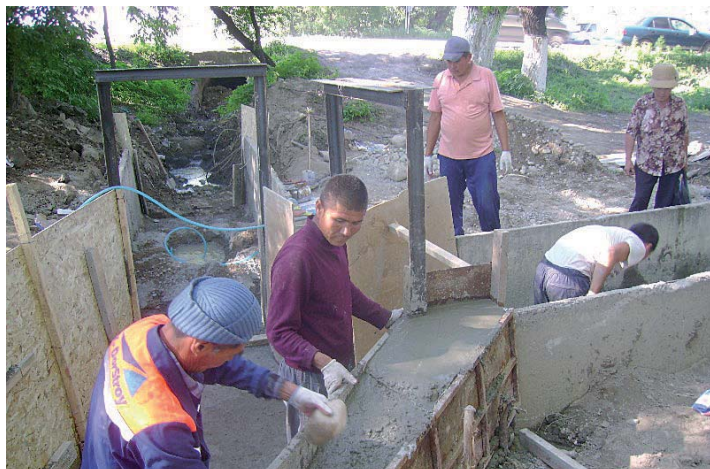
Строительство оросительного канала в селе Алга, Казахстан
