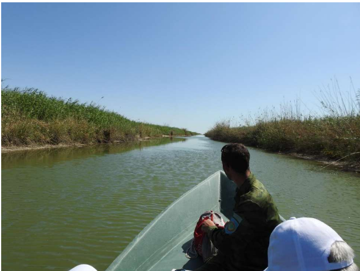
Фото 7. Обследование по каналу Приморский
