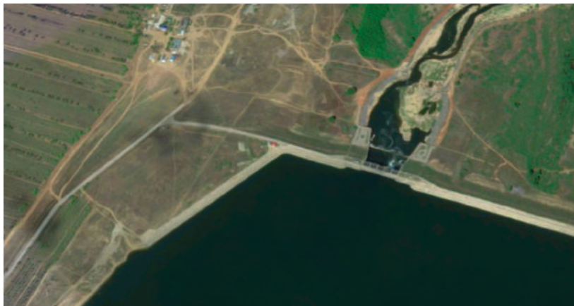
РИСУНОК 1 ВИД ГИДРОУЗЛА СВЕРХУ. GOOGLE MAPS
