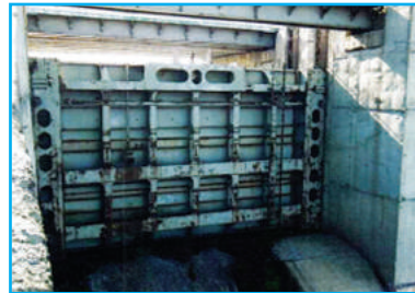
РИСУНОК 3 ЭКСПЛУАТАЦИОННЫЙ ВОДОСБРОС ВИД С НИЖНЕГО БЬЕФА
