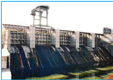
РИСУНОК 4 ПЛОСКИЙ ЗАТВОР ВИД С НИЖНЕГО БЬЕФА
